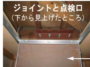
鋼製ポールをアルミでカバー (JIS規格の角型鋼管 200×200, t=9 or 12)
